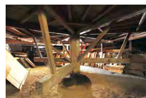
奈落には、石に丸穴を開け柱を入れたコマ回し式の仕掛けがあり、十文字の柱に4～5人が取り囲んで舞台をまわします。
