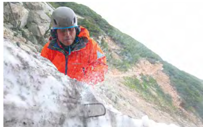
6～7月には登山道に残る雪渓を安全に歩けるようチェーンソーで切り出します。他にも落石ネットを張ったりくさり場のアンカーを止めたりと登山道整備の作業は多岐にわたります。
