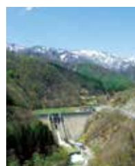
奥穂花ダムと奥穂花発電所・奥穂花第2発電所
